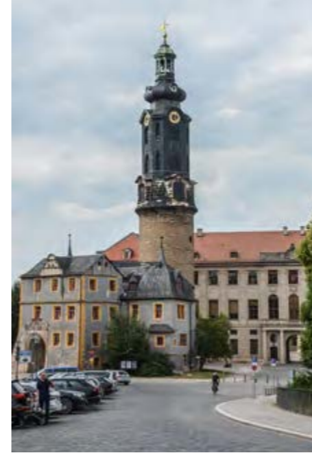
Foto rechts: Das Stadtschloss Weimar wird gerade saniert.
