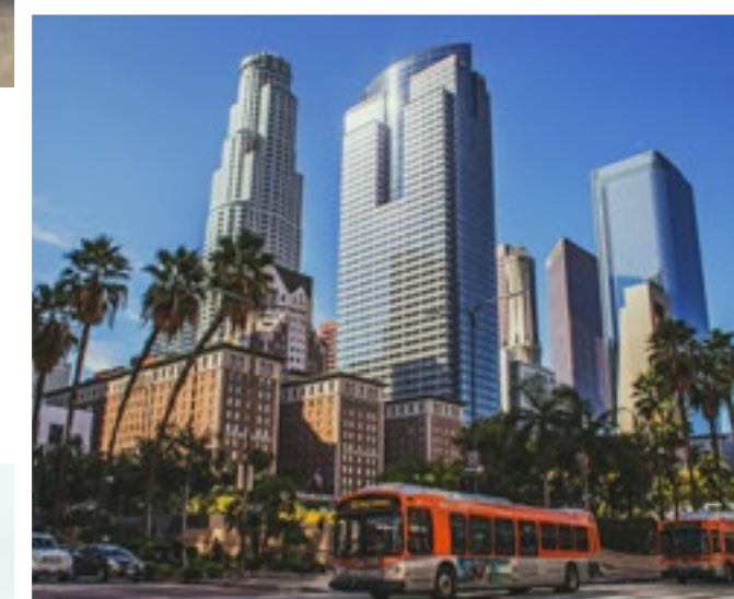
Foto unten: Bürogebäude in Downtown
